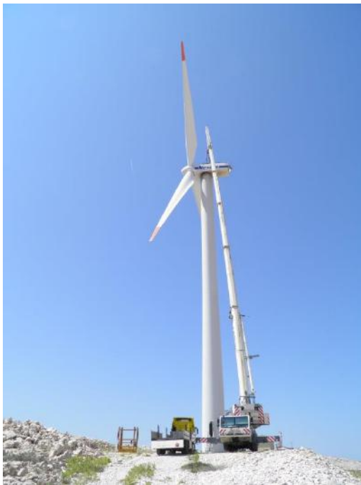
Slika 2. Demontaža prijenosnika snage na vjetro-elektrani RAVNE 1
