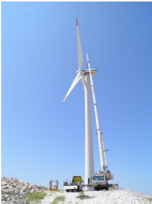
Slika 2. Demontaža prijenosnika snage na vjetro-elektrani RAVNE 1
